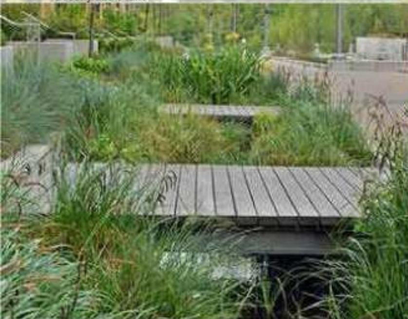
Priklad prechodov cez swale (rigoly v lúke)
